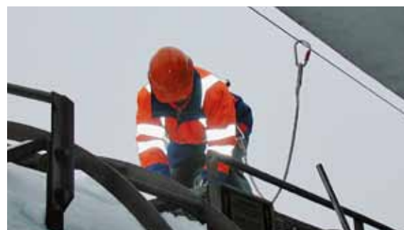
Processus amélioré: le prélèvement d'échantillons a lieu à la rampe du hangar de conditionnement, où il est possible d'assurer le collaborateur contre une éventuelle chute.
